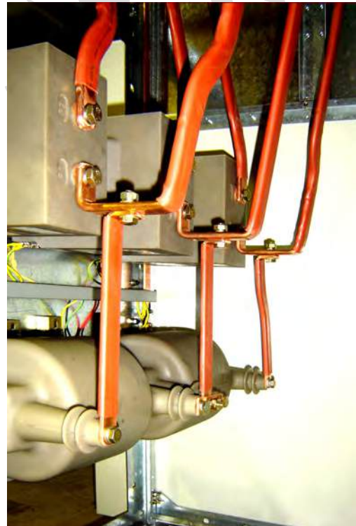
شکل (۱۱): نمای داخلی یک نمونه سلول اندازه گیری تابلوی فشار متوسط کمپکت AIS
