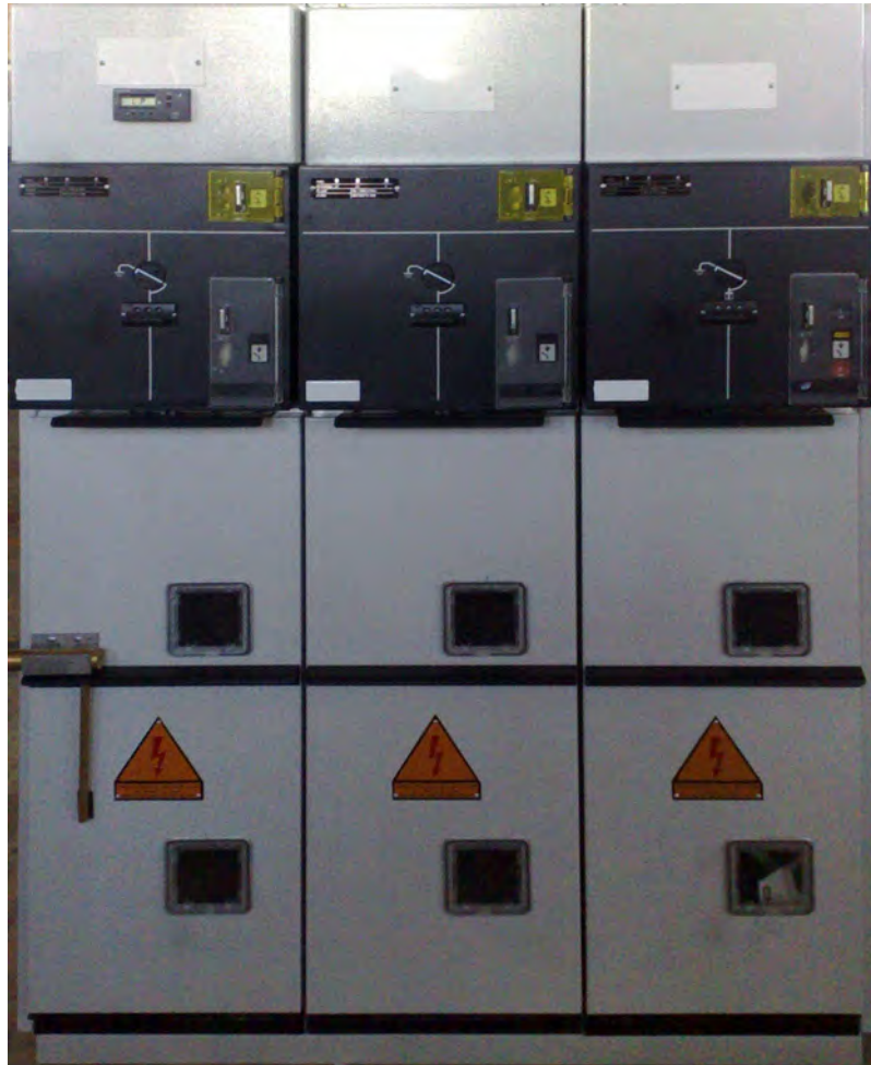
شکل (۱): یک نمونه تابلوی کمپکت AIS
