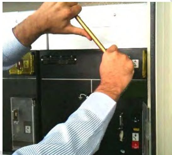
شکل (۴۳): زمین کردن فیدر متصل به سکسیونر توسط دسته باز و بست
