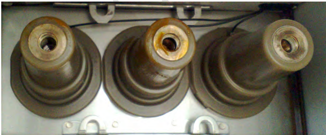
شکل (۲۶): نمونه‌ای از محل اتصال سرکابل‌های چپقی (پوشینگ‌های پلاگ-این)
