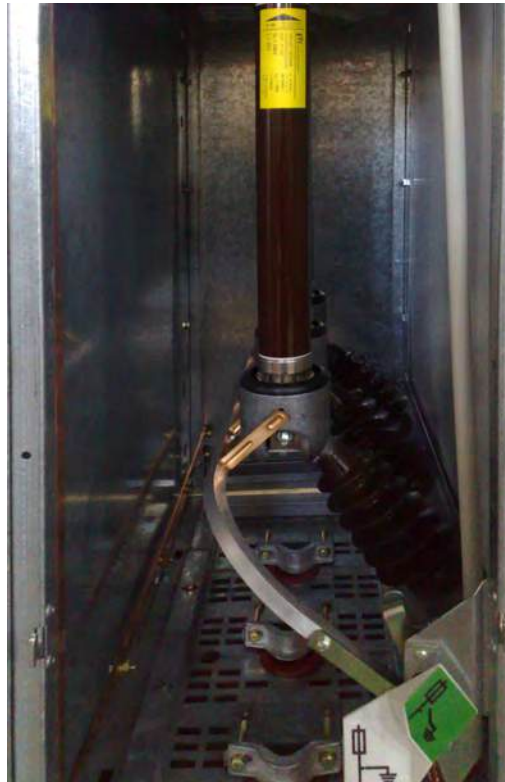
شکل (۴۰): سکسیونر فیوزدار قابل قطع زیربار
