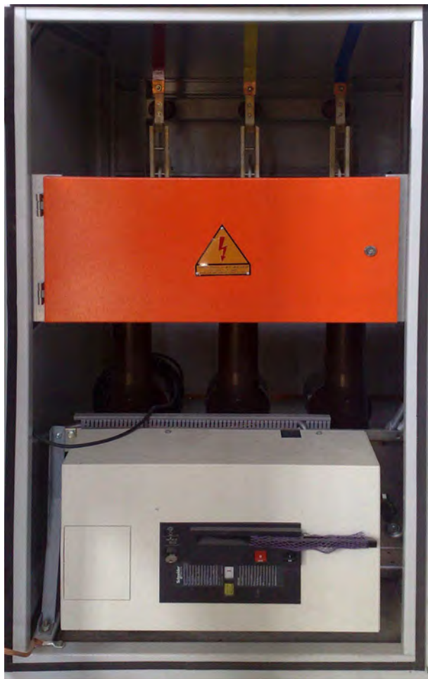
شکل (۲۸): نمونه‌هایی از پوشش‌های حفاظتی نصب شده در تابلوهای فشار متوسط معمولی
