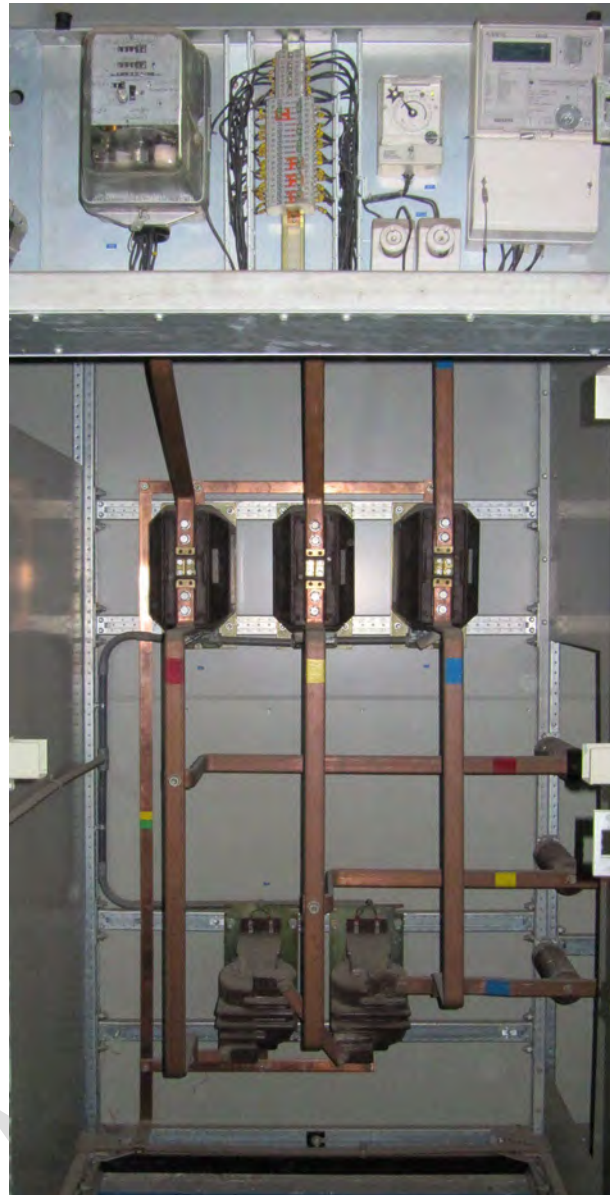
شکل (۹): یک نمونه سلول اندازه‌گیری تابلوی فشار متوسط معمولی
