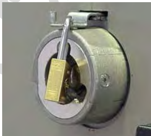
شکل (۳۶): قفل عملکرد سکسیونر یا کلید زمین
