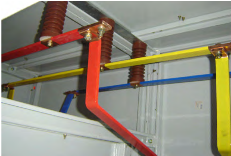
شکل (۱۱): نمونه‌ای از شینه‌های تابلوی فشار متوسط معمولی
