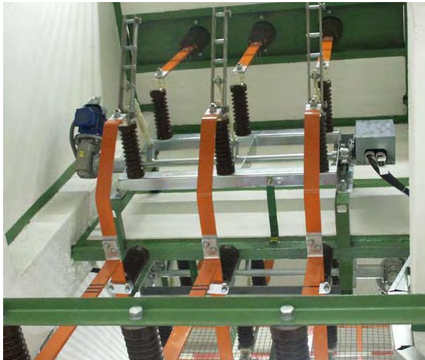
شکل (۶): نصب افقی سکسیونر غیر قابل قطع زیر بار داخلی با مکانیزم فرمان موتوری
