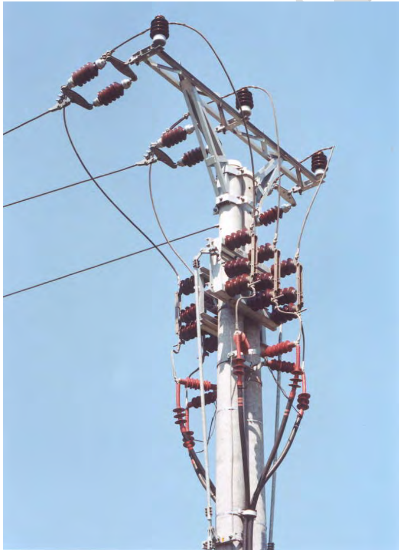
شکل (۱۳): نمونه‌ای از نصب عمودی سکسیونر بر روی پایه و اتصال شبکه هوایی به شبکه کابلی
