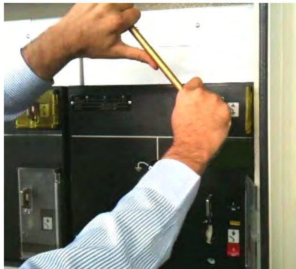
شکل (۱۸): زمین کردن فیدر متصل به سکسیونر توسط دسته باز و بست
