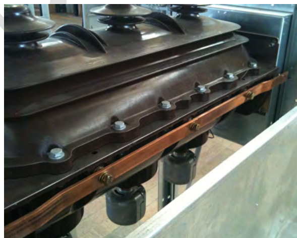
شکل (۱۷): شینه اتصال زمین یک نمونه سکسیونر قابل قطع زیر بار گازی
