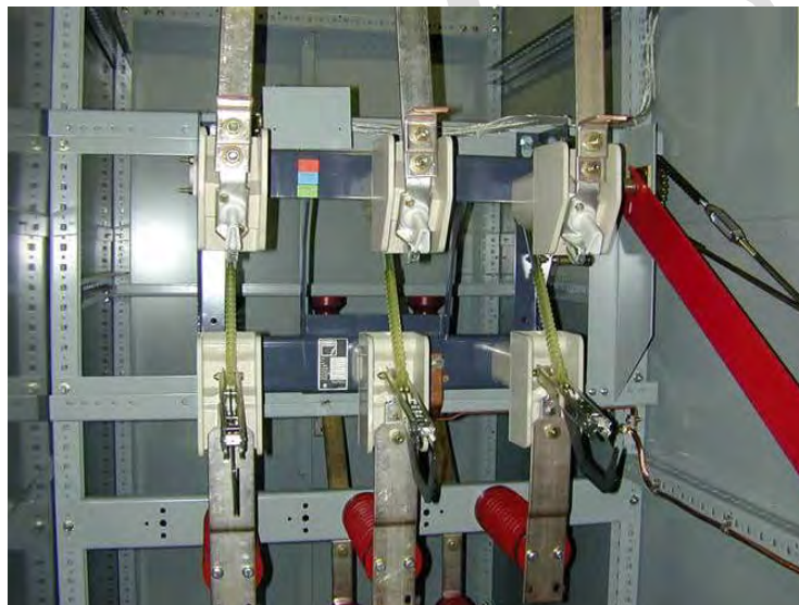
شکل (۱۵): نصب عمودی سکسیونر قابل قطع زیر بار داخلی با عایق هوا
